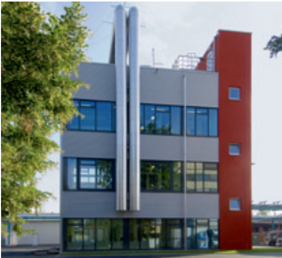
Die neue Wirkstoffproduktionsanlage der Degussa im Industriepark Wolfgang (Fotos: IPW)
